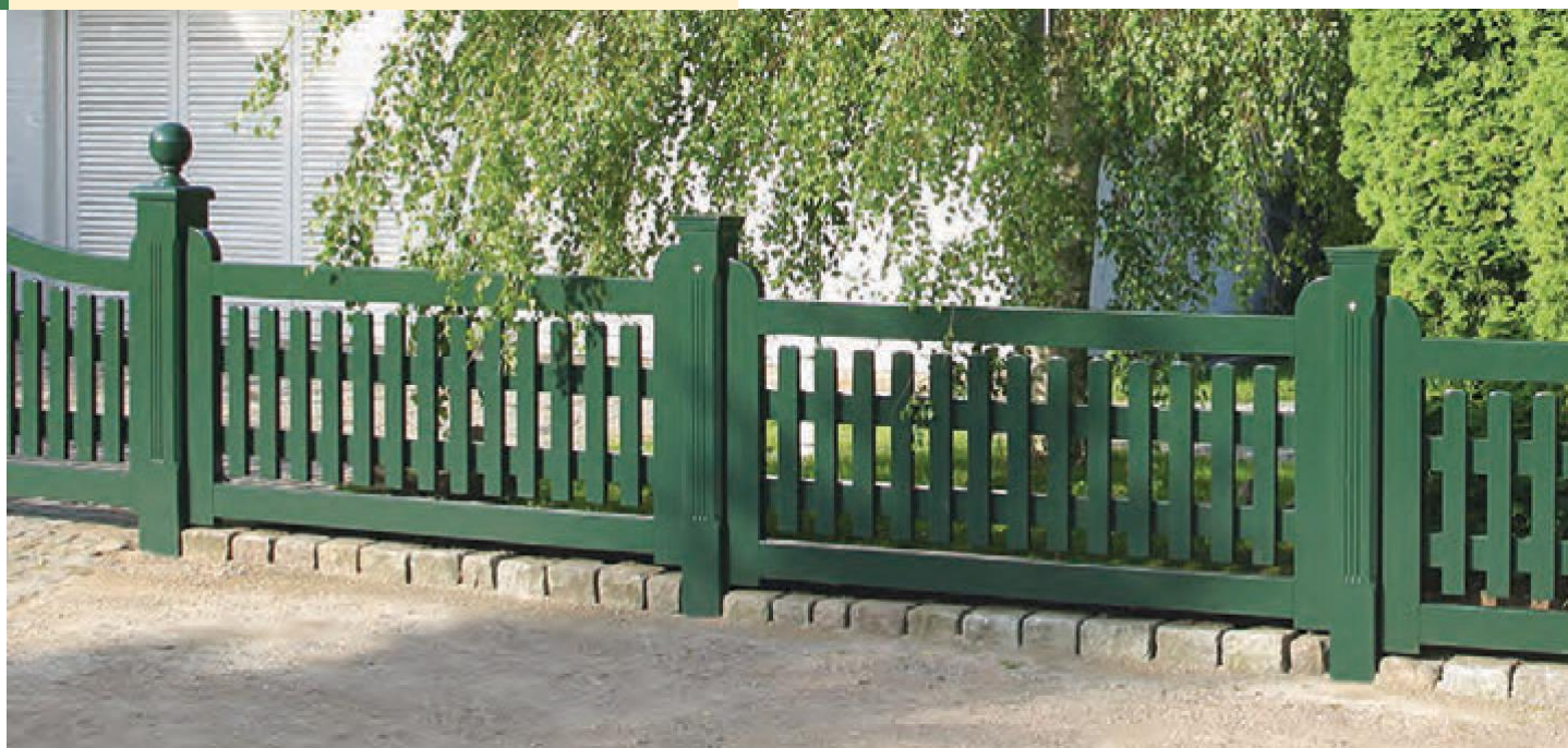
Et smukt hegnssystem - særligt kraftige lågestolper (18 x 18 cm med kugleafdækning Romantik ), hegnselementer efter kundens skitse.
