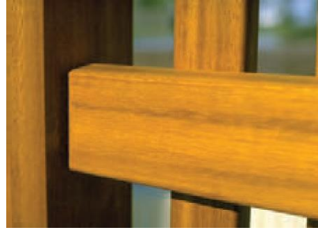
3. Hegnselementernes skråt skårne tværbjelker
