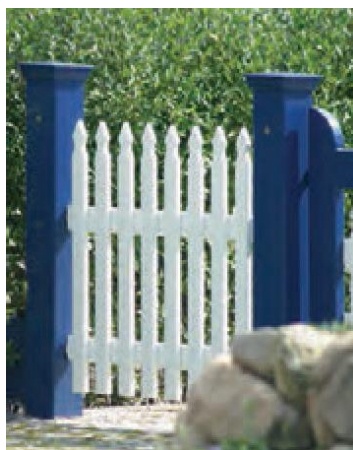
Stolper med Klassik-afdækning.
